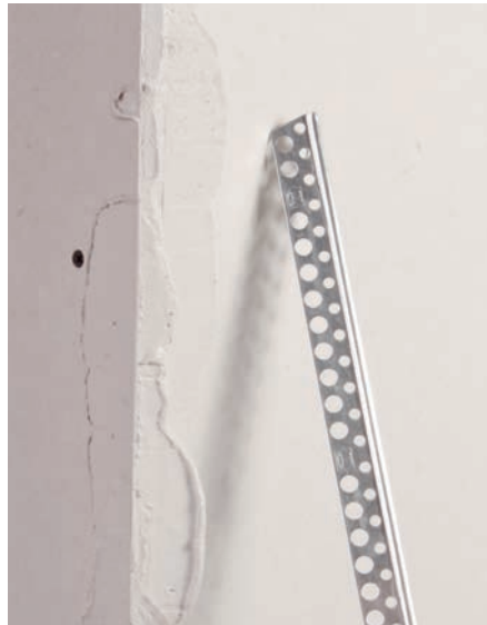
Fugenfüller auf Kante auftragen
