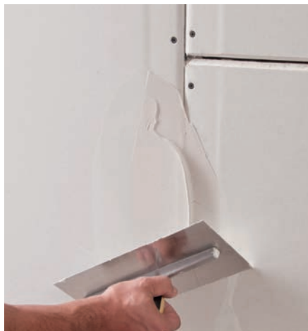
Längskante quer zur Fuge füllen
