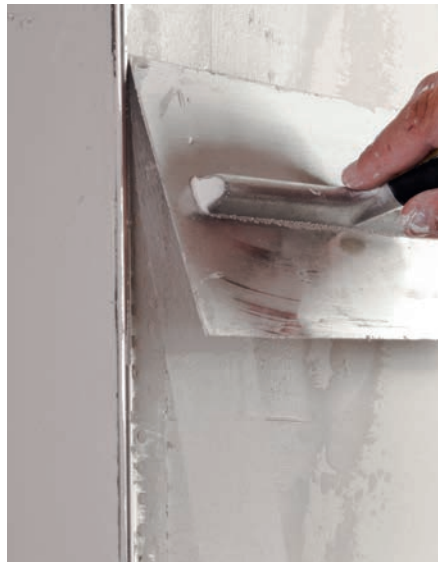
Bewehrungsstreifen (optional) beidseitig einspachteln
