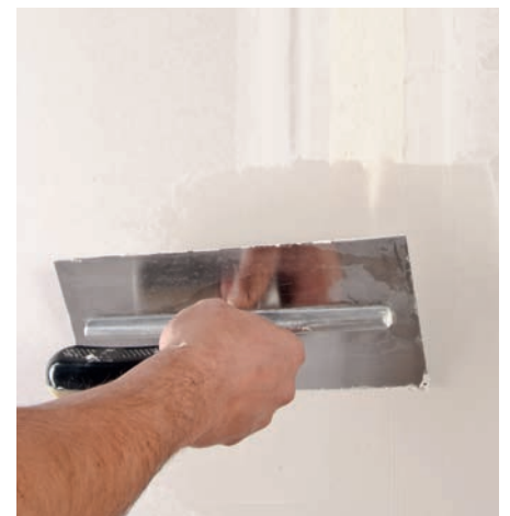
Zweite Spachtelschicht über Bewehrungsstreifen
