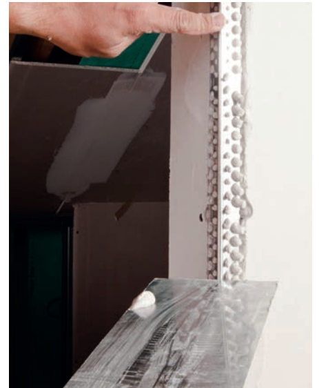
Kantenprofil eindrücken
