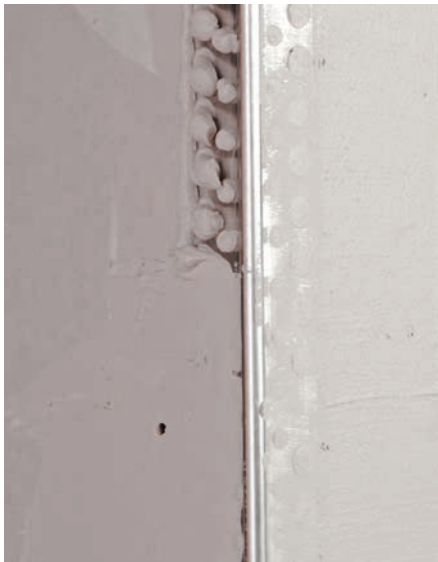
Ersten Spachtelgang aufziehen
