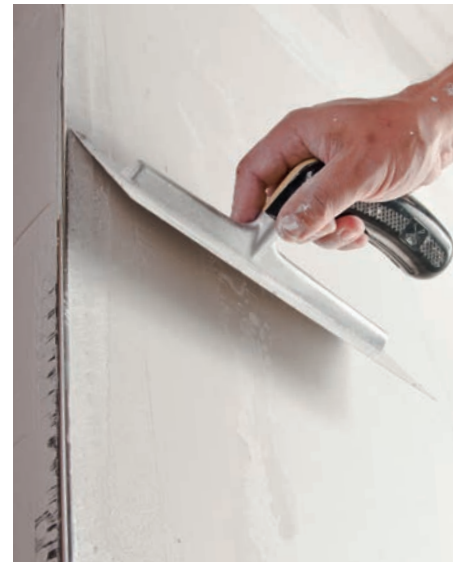
Breites Ausziehen der Spachtelkante in die Fläche
