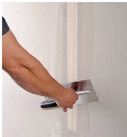
Bewehrungsstreifen glatt ziehen; Spachtelschicht abbinden lassen
