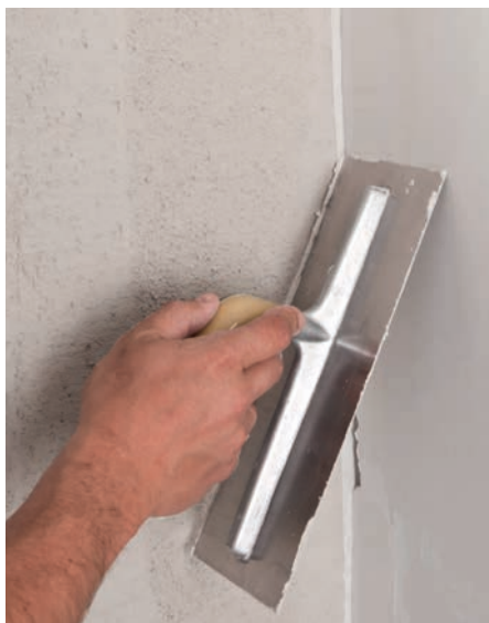
Alternativ: Anbringen von selbstklebendem Trennstreifen/Malerband zur kontrollierten Material-Trennung, anschließend verspachteln. Nach dem Trocknen der Fugen das noch sichtbare Malerband wieder entfernen.
