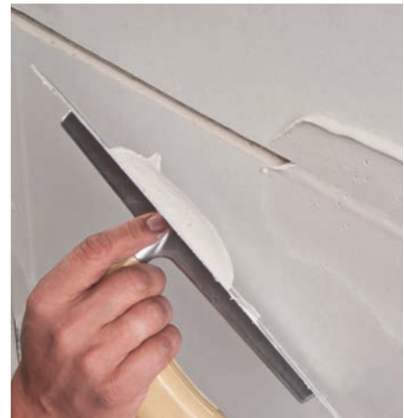
Beim ersten Spachtelgang: Querkante quer zur Fuge füllen
