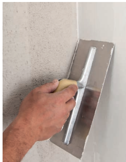
Alternativ: Anbringen von selbstklebendem Trennstreifen/Malerband zur kontrollierten Material-Trennung, anschließend verspachteln. Nach dem Trocknen der Fugen das noch sichtbare Malerband wieder entfernen.
