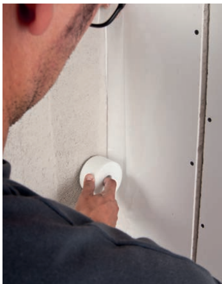
Alternativ: Anbringen von selbstklebendem Trennstreifen/Malerband zur kontrollierten Material-Trennung, anschließend verspachteln. Nach dem Trocknen der Fugen das noch sichtbare Malerband wieder entfernen.
