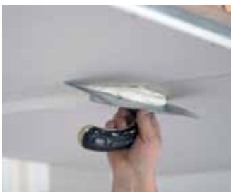
Spárování a tmelení
