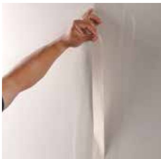
Papírová a skelná páska se vkládá do vrstvy tmele
