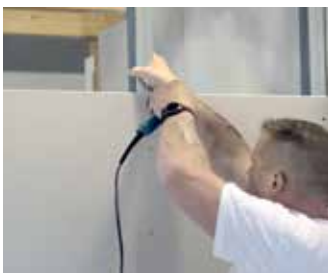
Montáž opláštění
