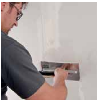
Případná třetí vrstva - roztažení do šířky
