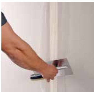
Přetažení pásky tmelem
