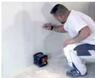
Vyměření polohy příčky
