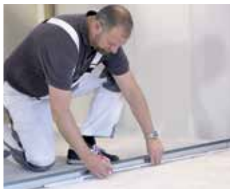
Vyměření polohy profilů CW
