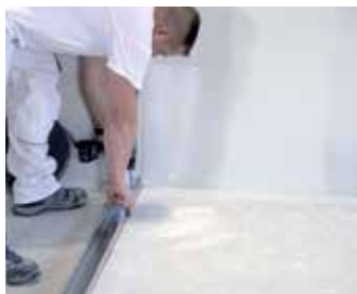
Montáž obvodových UW profilů
