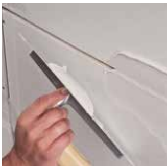
Nanášení tmelu do příčné spáry
