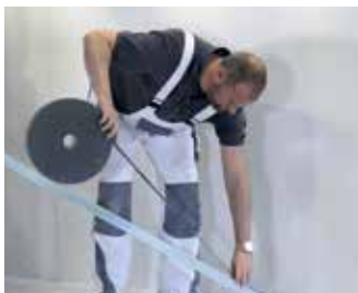
Podlepení profilů těsnící páskou
