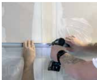
Vyměření konstrukce podhledu
