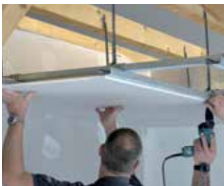
Montáž opláštění
