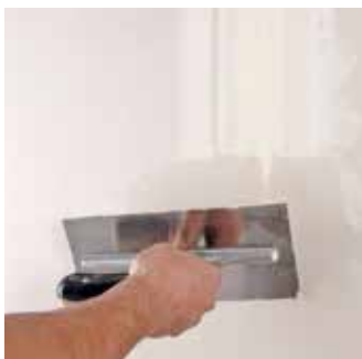
Druhá vrstva tmele aplikovaná po dostatečném vyschnutí první vrstvy
