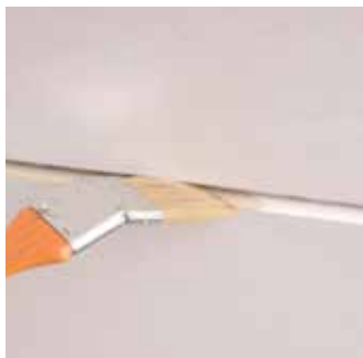
Ošetření řezané spáry
