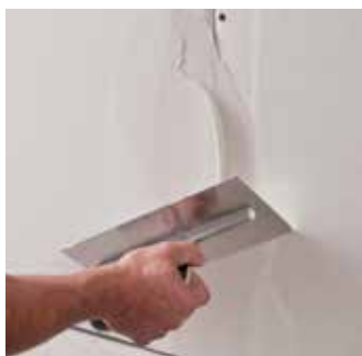
Tmelení podélné spáry
