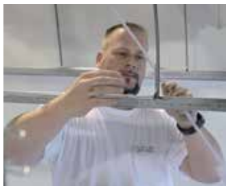
Osazení profilů na závěsy a vyrovnaní
