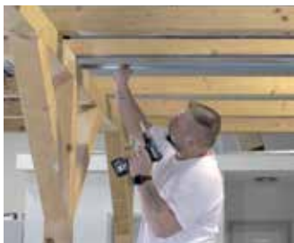
Podlepení profilů těsnící páskou
