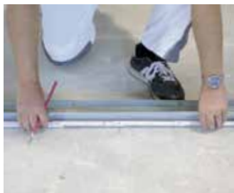
Montáž obvodových UW profilů
